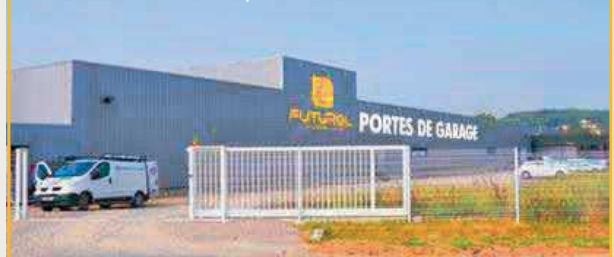
Usine de Saint Loup 1
