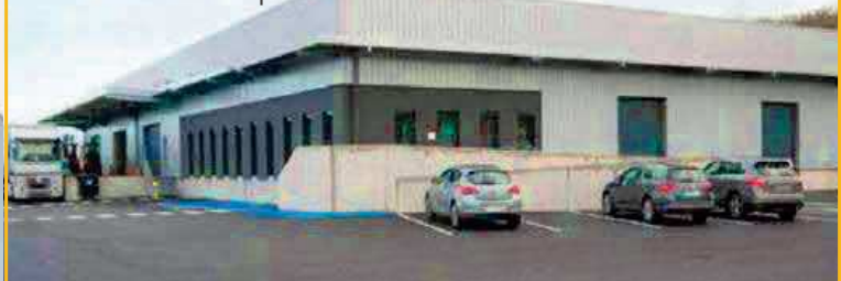
Usine de Saint Loup 2
